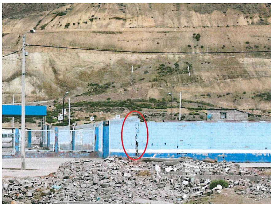
Foto 7. Los muros y juntas del Terminal Terrestre de Morococha antigua presentan fisuras, podrían colapsar y afectar algún morador.
