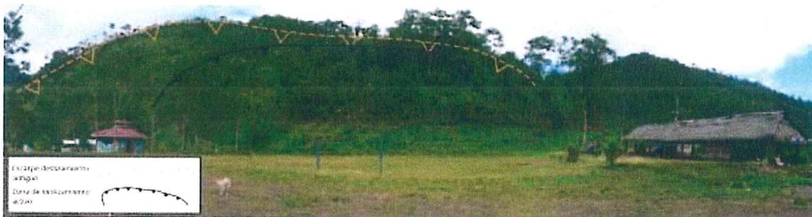
Figura 11. Deslizamientos en el talud carretero de la zona del colegio primario de Pitocuna.
