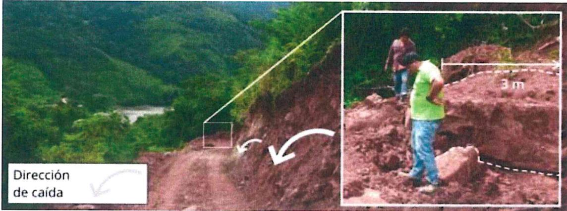
Figura 18. Talud de corte inestable que genera derrumbes y caída de rocas..
