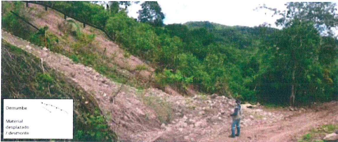
Figura 19. Talud inestable, que muestra derrumbe.
