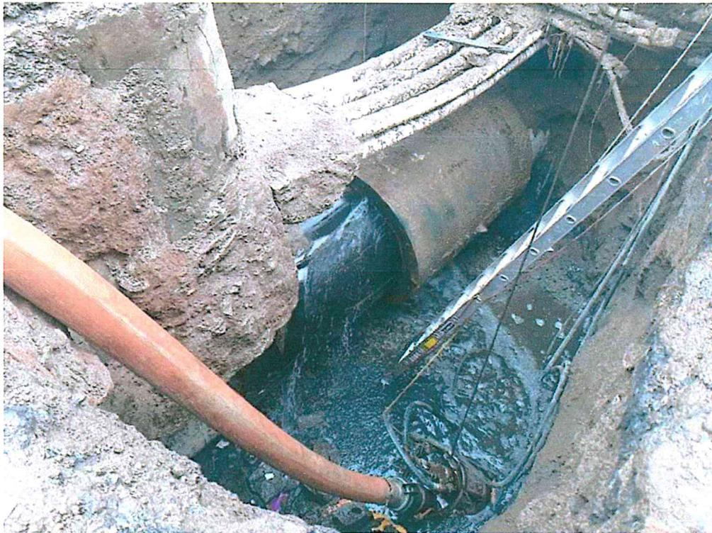
Foto 2: Daños a tuberías de agua en Iztapalapa tras terremoto.
