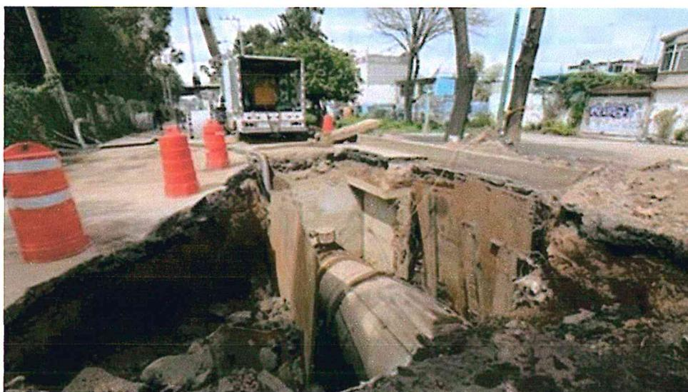
Foto 1: Daños a tuberías de agua en Iztapalapa tras terremoto.
