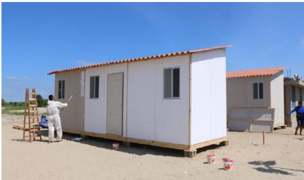
Figura 2. Instalación de Módulos temporales de vivienda para damnificados por El Niño
