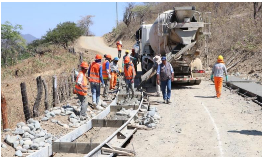
Figura 06. Reconstrucción de carreteras por El Niño Costero
